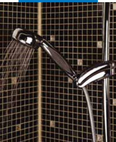
Esempio di rivestimento in tessere di mosaico vetroso in un box doccia stuccate con Ultracolor Plus
