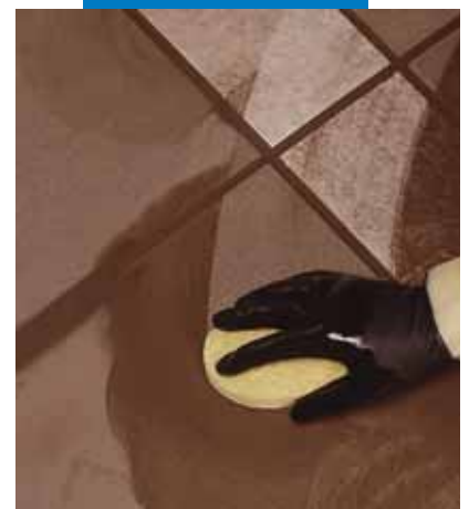
Pulizia e finitura delle fughe con spugna
