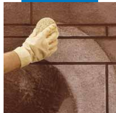
Pulizia e finiture delle fughe con spugna
