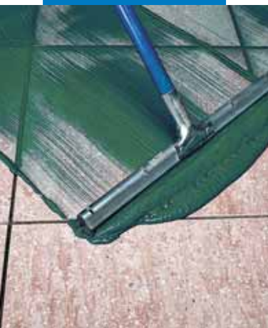
Stesura di Ultracolor Plus a pavimento con racia
