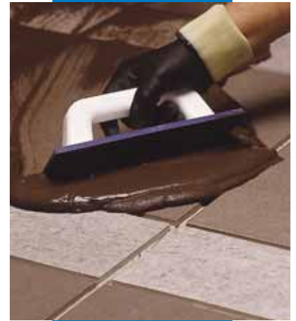
Stesura di Ultracolor Plus a pavimento con spatola in gomma
