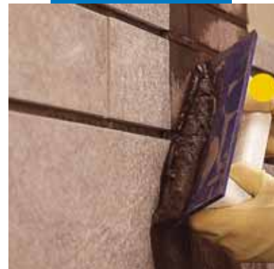
Stesura di Ultracolor Plus a parete con spatola di gomma
